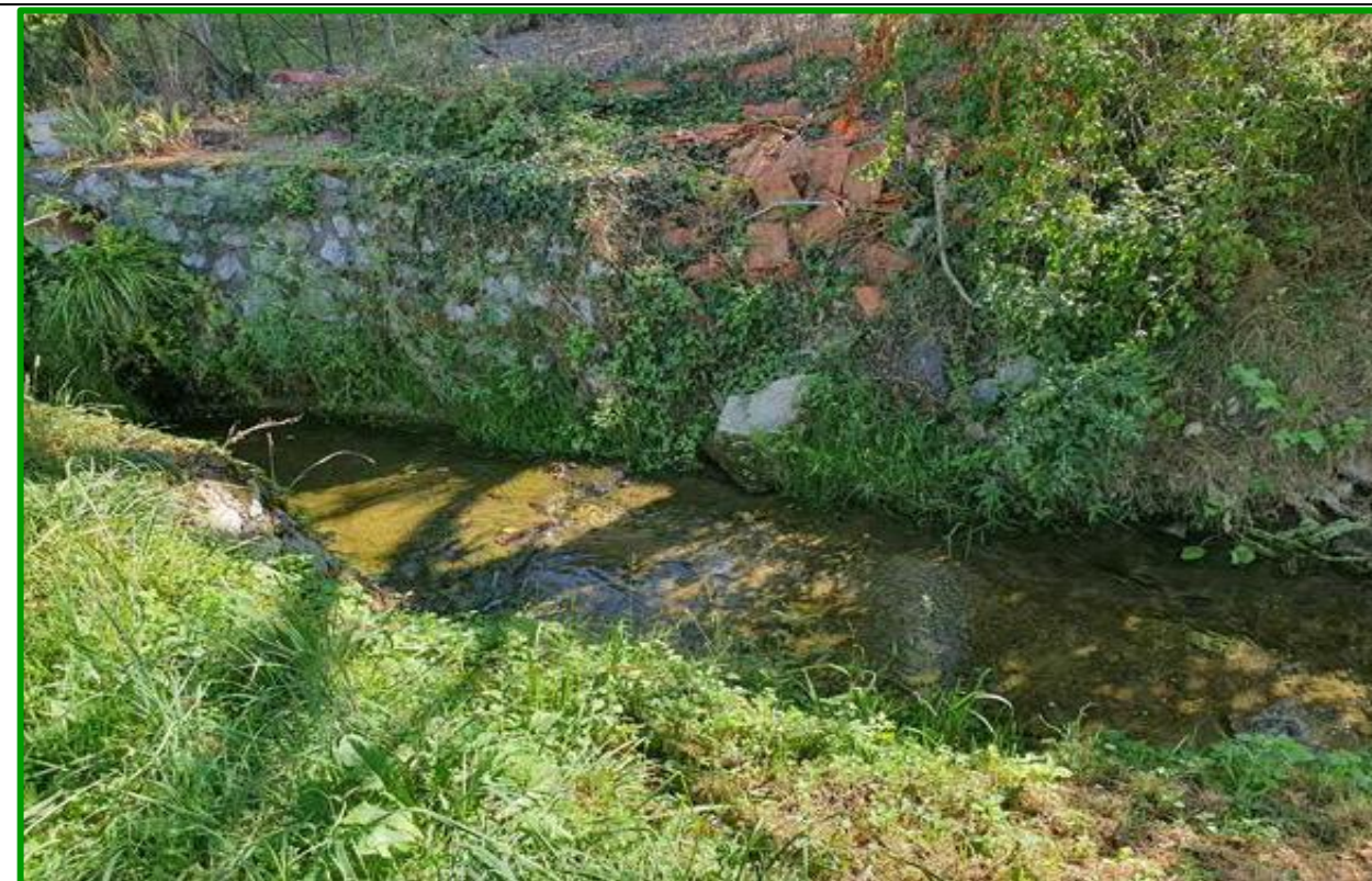
Slika 20. Potok Čučerska Reka – stacionaža km 0 + 480,00 – postojeća obloga korita (Izvor: Tau projekt d.o.o.)
