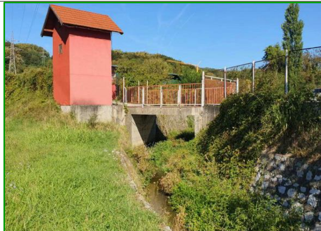
Slika 22. Potok Čučerska Reka – most uzvodno od predmetne dionice (Izvor: Tau projekt d.o.o.)
