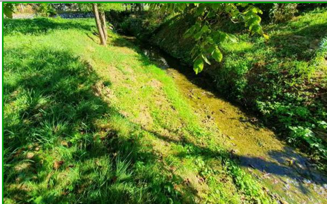
Slika 19. Potok Čučerska reka - stacionaža km 0+460,00 (Izvor: Tau projekt d.o.o.)
